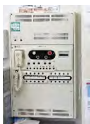
「非常用放送設備」 火災を知らせる館内用のマイクとサイレンが鳴る設備
